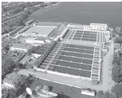
写真2 日本の無償資金協力で建設されたプノンペン市ポンプレック浄水場
