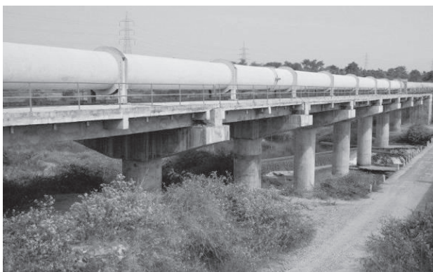
写真5 日本の円借款により建設された、 インド・バンガロール市までの100kmに及ぶ送水管
