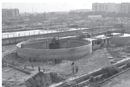
写真4 日本の円借款によるデリー市オクラ下水処理場の建設風景
