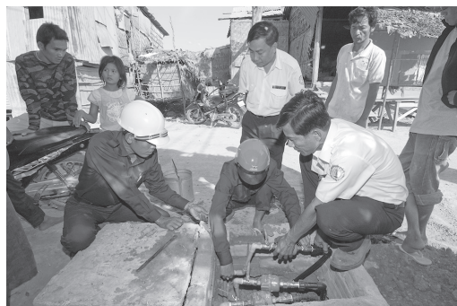
写真3 配水管の点検を行うプノンペン水道公社の職員。北九州市の協力を得たJICAの技術協力により、職員の能力は大きく向上した
