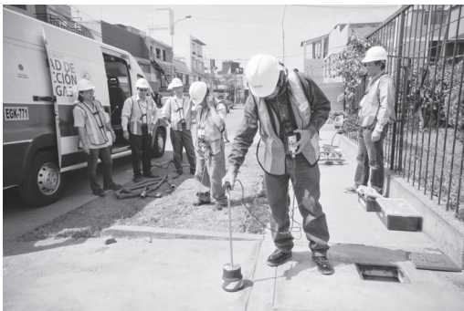
写真6 ペルー『リマ上下水道公社無収水管理能力強化プロジェクト』における漏水調査の様子
